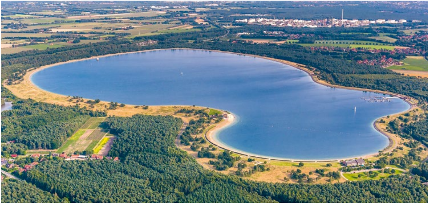
Das Atomkraftwerk Emsland nutzt Kühlwasser aus der Ems, kann bei Bedarf aber auch auf das eigene Speicherbecken in Geeste zurückgreifen.
