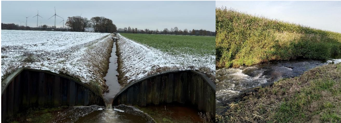
Abbildung 15: (links) Sohlabsturz in der Ossenbeeke, (rechts) Sohlgleite im Hestruper Mühlenbach
