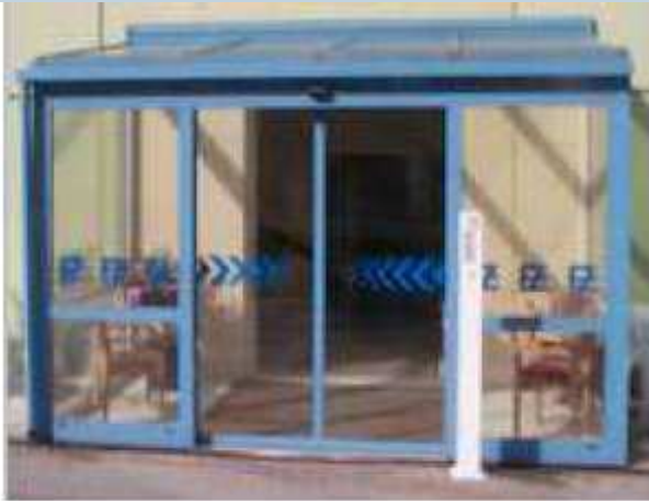
Sensor oberhalb des Durchgangs
