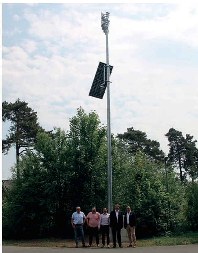
Am Feldkamp/Ecke Bramhaarweg in Meppen erhielt 2023 als einer der ersten Standorte im Landkreis eine neue Mastsirene.
