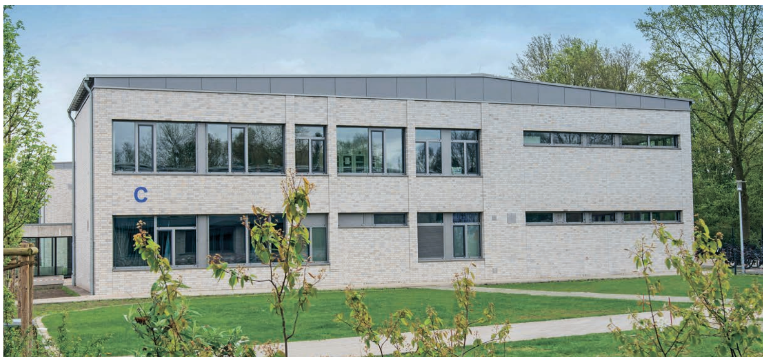
Energetisch komplett saniert wurde am Gymnasium Papenburg auch dieser Fachunterrichtstrakt, das Gebäude C.
