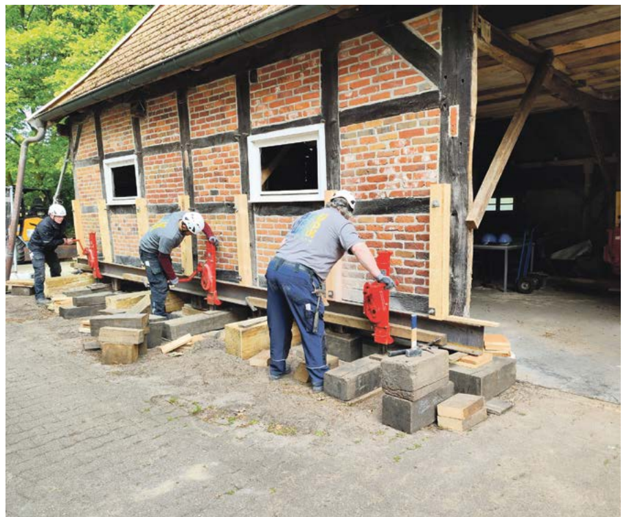
Hof Rosen: Das Fachwerkhaus wurde erst kürzlich um 60 cm angehoben, weil es über Jahre hinweg abgesackt war. In der historischen Bausubstanz entstehen nach der umfassenden Sanierung Ferienwohnungen und ein Kursraum für Achtsamkeitstrainings.
